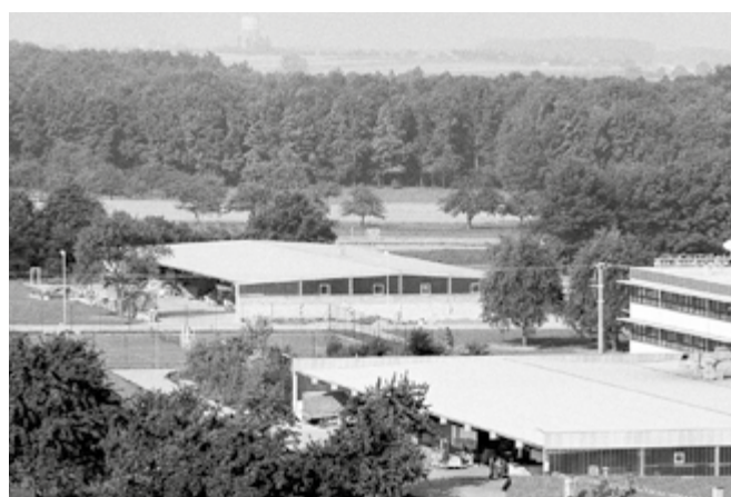
1978 Bezug Fertigungshalle für die mechanische Teilefertigung und Galvanik
